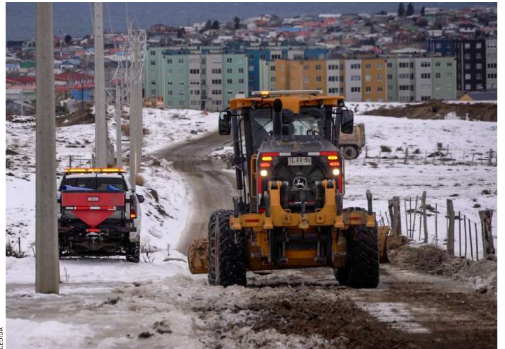
El despliegue de maquinaria y cuadrillas se mantiene operativo en la ciudad y zonas periurbanas, para la mantención y el despeje de caminos.
