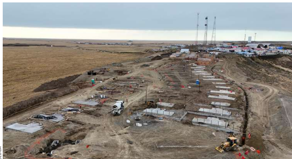
Las obras del proyecto registran un avance superior al 28%.
