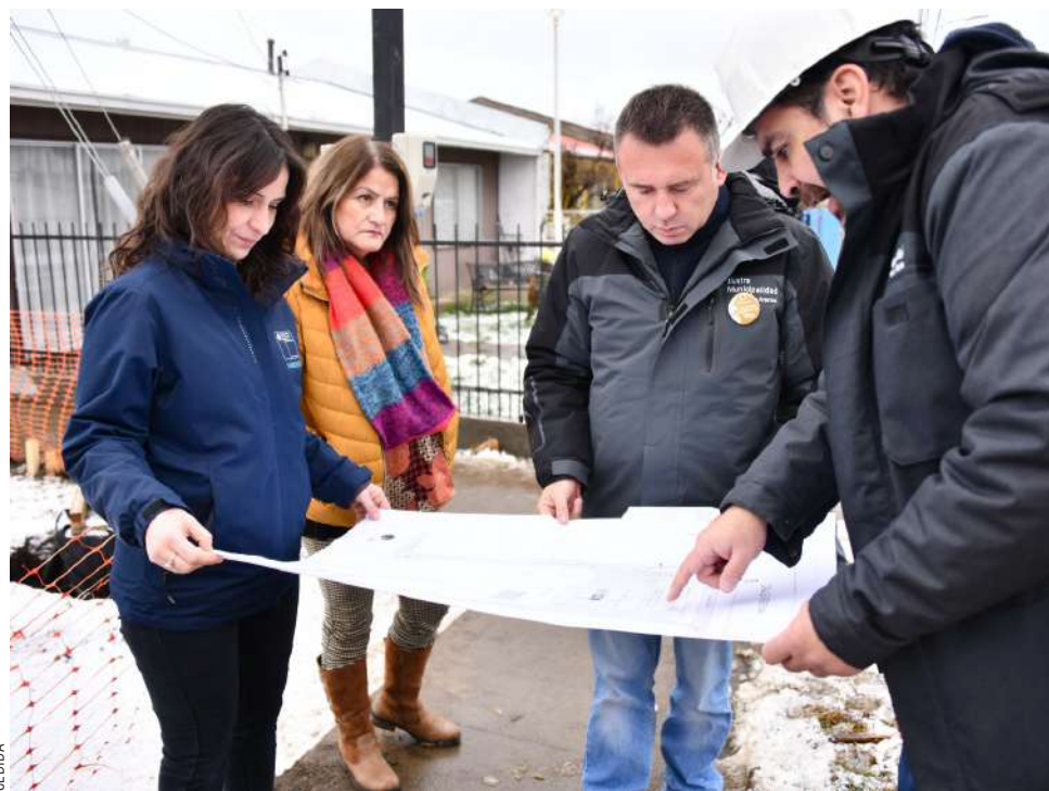
Las obras llevan un 30% de ejecución y se espera que finalicen a fin de año.
