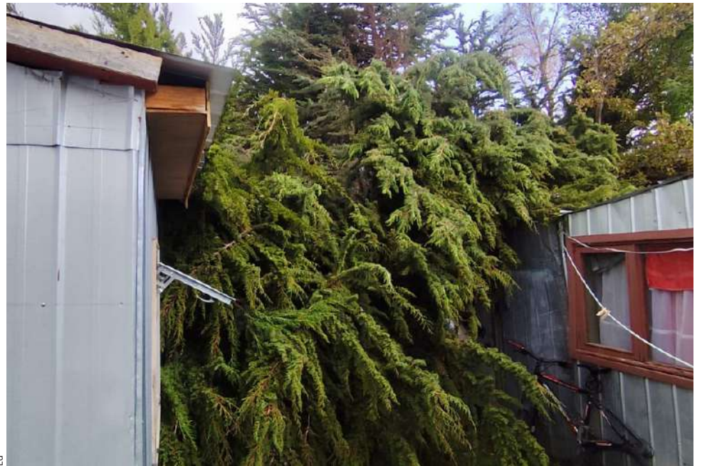
El gancho de un árbol cayó sobre dos viviendas interiores del Barrio Prat de Punta Arenas.
