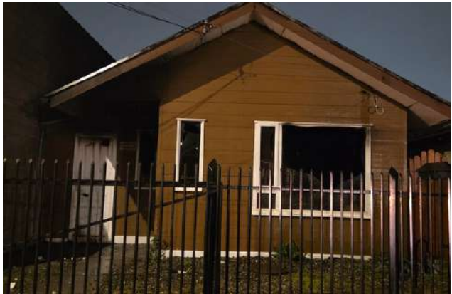
El fuego, humo y agua dejaron pérdidas totales en la vivienda situada en el sector poniente.
