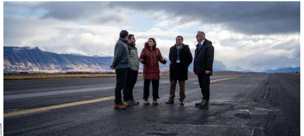
MOP presenta plan de trabajo para reparar pista del aeródromo de Puerto Natales.
