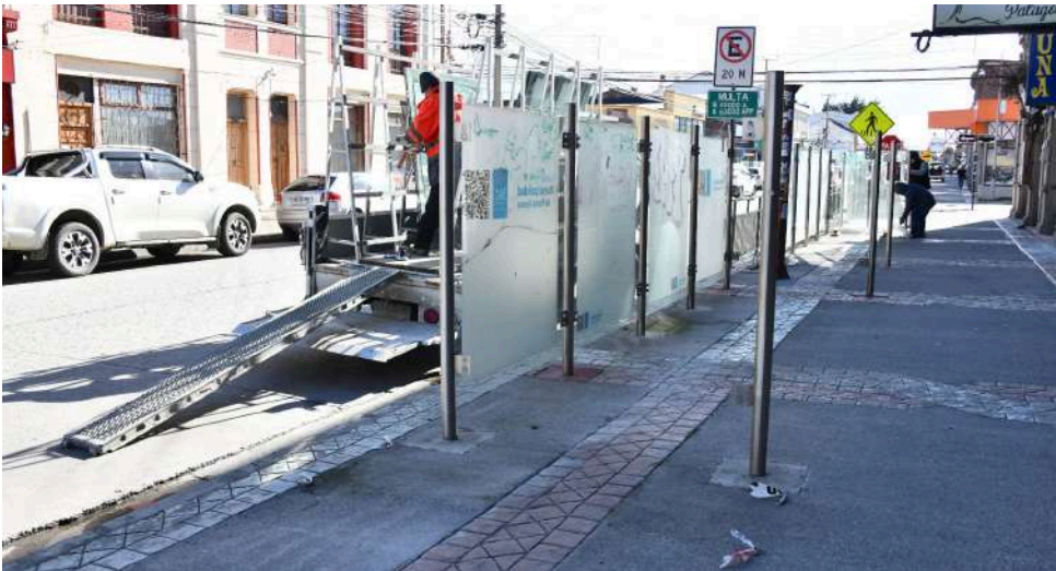
Retiro de los paneles instalados en pandemia en calle O'Higgins.
