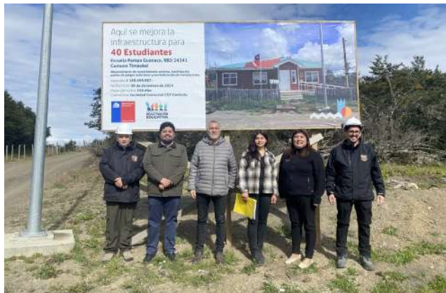
En Pampa Guanaco se está ejecutando un importante obra de conservación.
