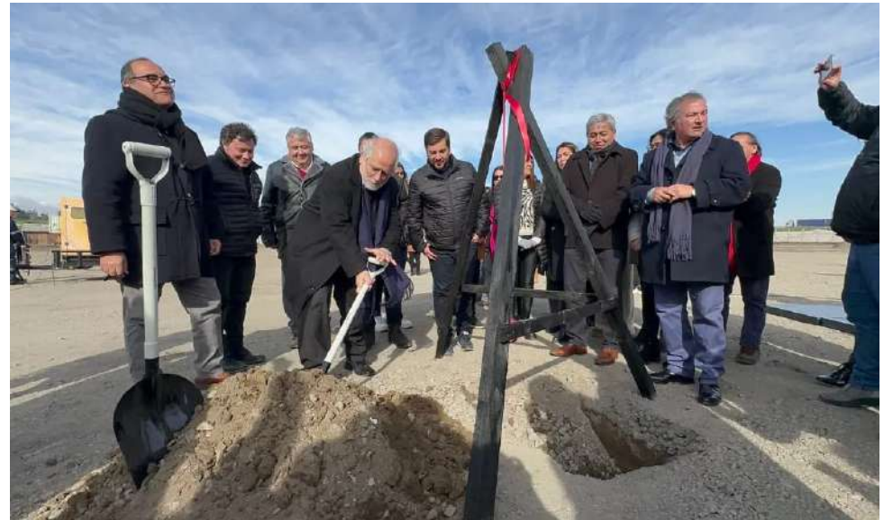
Carlos Montes, puso la primera piedra del proyecto habitacional que recibirá a 104 familias de Requínoa.
