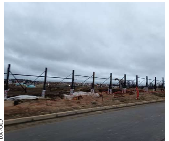
Las obras de mejoramiento del Parque consideran la remoción de las rejas.
