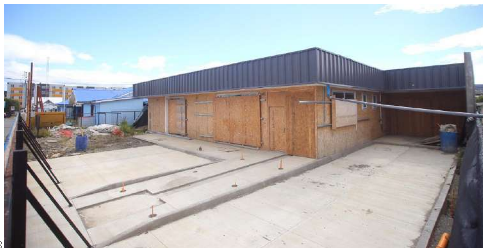
El abandono de obras de la antigua empresa constructora, retrasó todos los planes. Este año el SAR Damianovic, puede ser una realidad.
