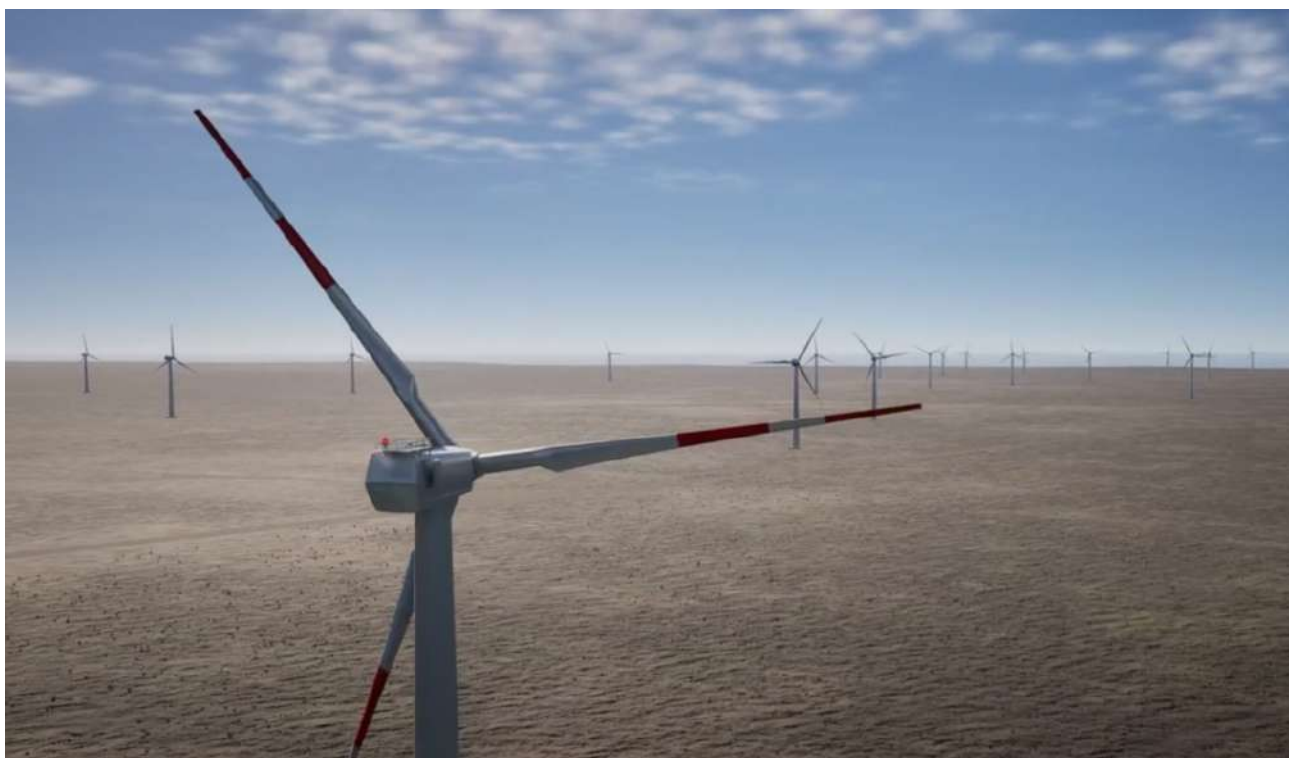
EL PARQUE EÓLICO DE HNH EN SAN GREGORIO GENERARÁ UNA POTENCIA DE 1,4 GW DESTINADOS A ALIMENTAR EL PROCESO DE ELECTROLISIS NECESARIO PARA GENERAR AMONIACO VERDE. EL PROYECTO ESTÁ EN CALIFICACIÓN.
