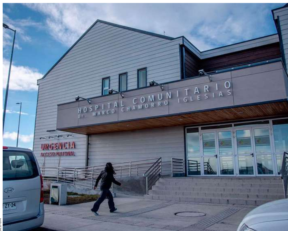
En el hospital de Porvenir se instalará la Unidad de Diálisis.
