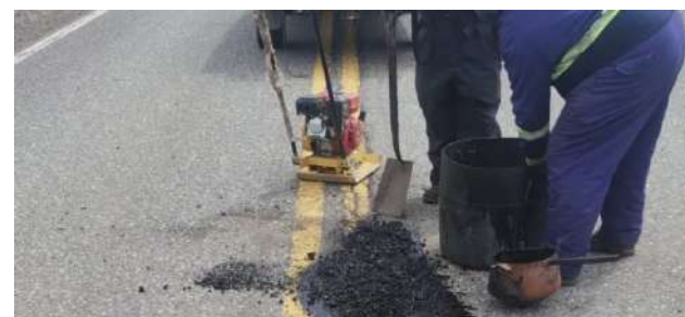
Los trabajos consideran las rutas N°3 y N°40.
