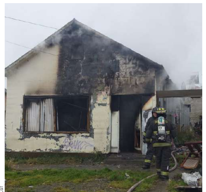
El incendio se desató a mediados de esta semana y destruyó por completo la vivienda de calle Arauco.
