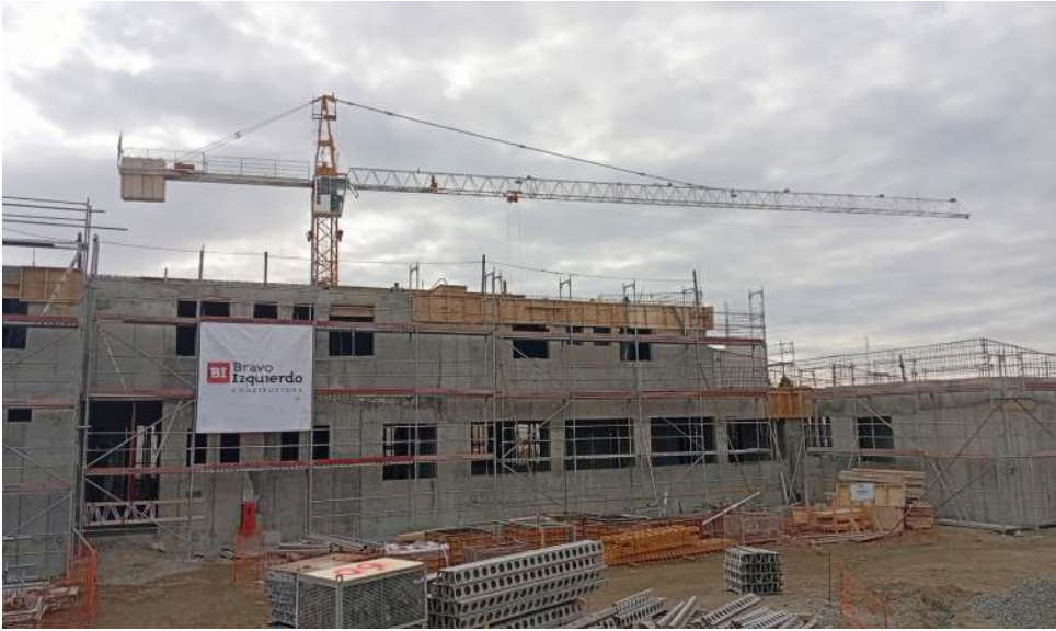
Gran parte de la obra gruesa del edificio principal de la comisaría ya está levantado.
