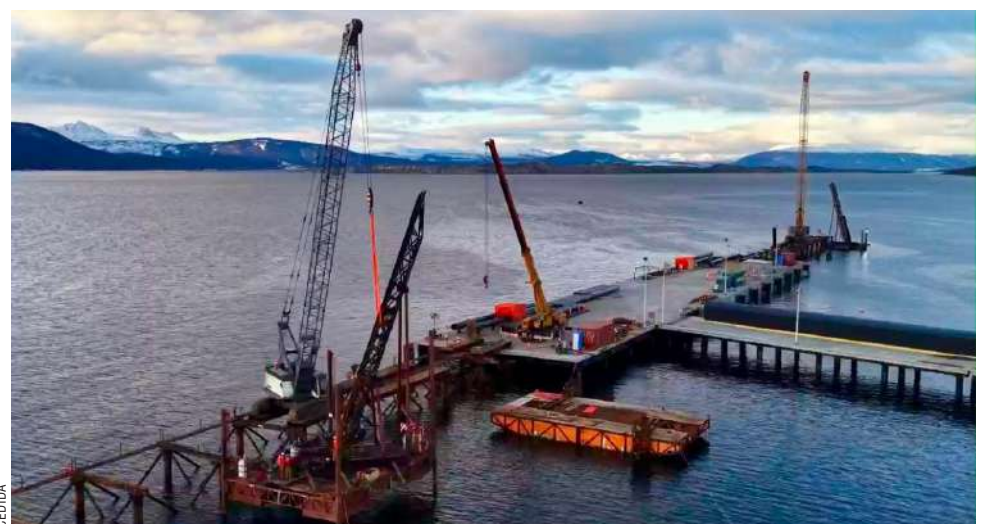
Muelle de Puerto Williams proyecta término en 2027 y refuerza logística científica.
