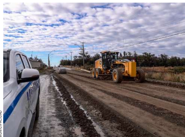
Maquinaria municipal trabajó desde temprana hora de ayer para reparar los caminos dañados.
