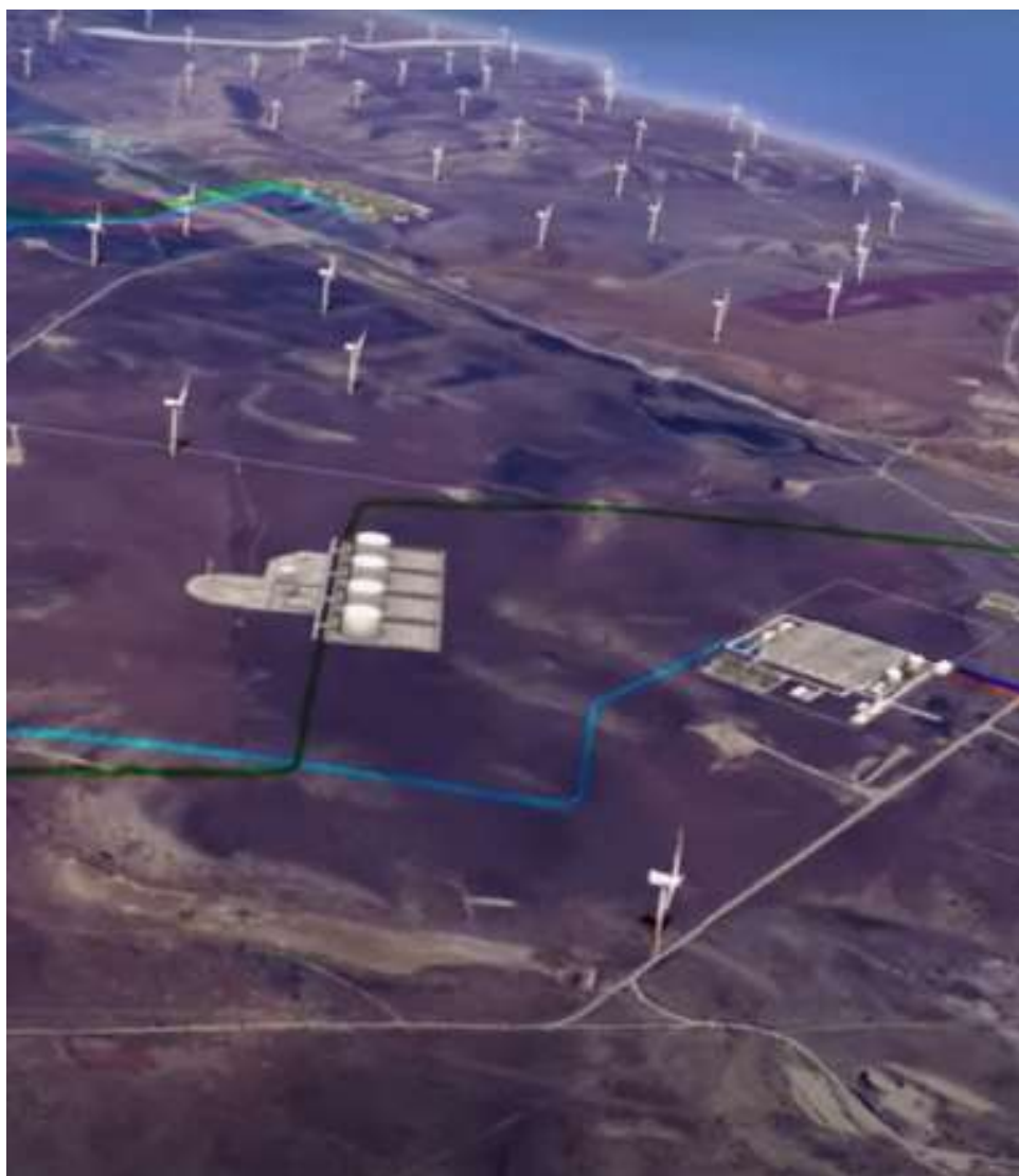
LA IMAGEN ILUSTRAS EL ASPECTO QUE PRESENTARÁN PARTE DE LAS INSTALACIONES DEL PROYECTO EN SAN GREGORIO.
