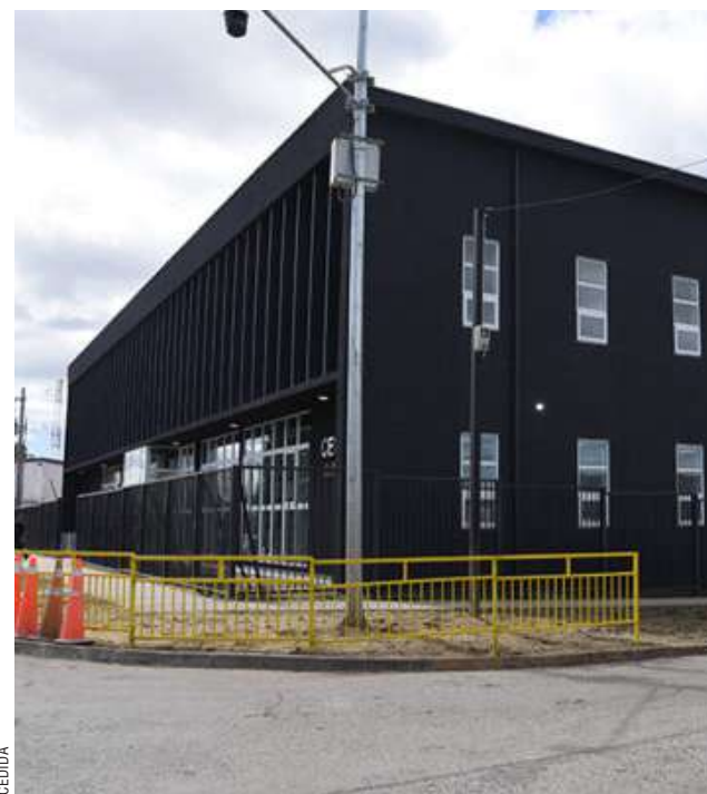
El nuevo edificio apronta su puesta en marcha para su inauguración.
