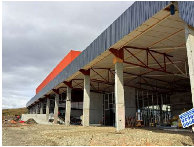
Autoridades realizaron una visita inspectiva a las obras del gimnasio Zavattaro de Porvenir.
