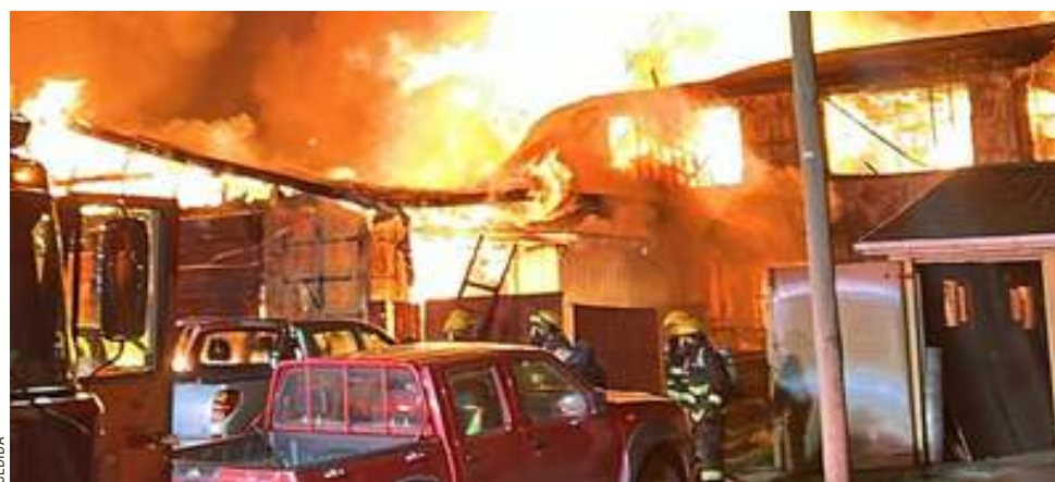
El fuego destruyó por completo las dos estructuras, debiendo Bomberos evitar la propagación.
