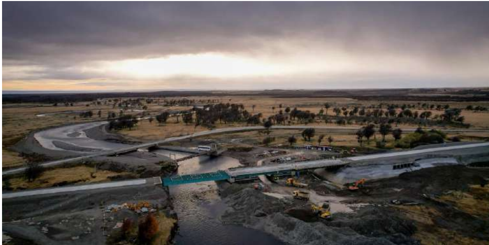
Avanzan los trabajos del nuevo Puente Río Rubens.
