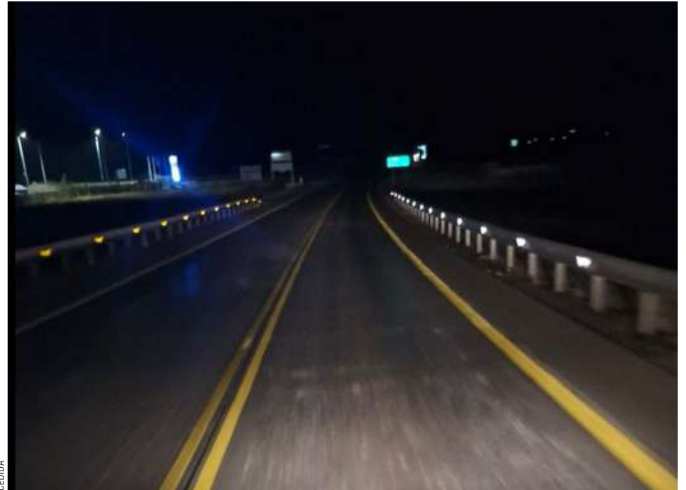
La falta de buena iluminación en la vía representa un importante riesgo para conductores y transeúntes que se desplazan por la Ruta 9 Norte.
