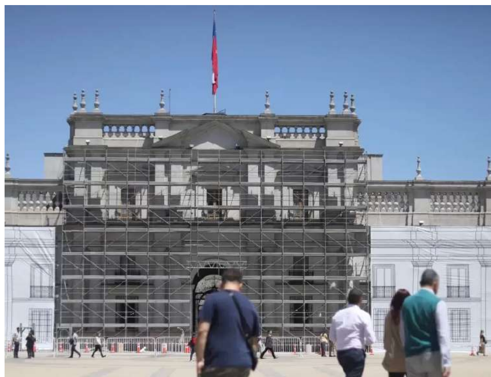
Los trabajos son liderados por el Ministerio de Obras Públicas (MOP) en conjunto con el Consejo de Monumentos Nacionales.
