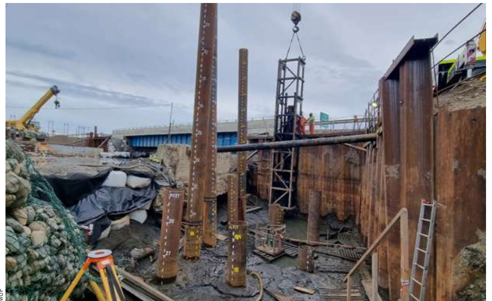
Los trabajos en el puente han enfrentado múltiples problemas, pero el MOP espera concluirlos a finales de este año.
