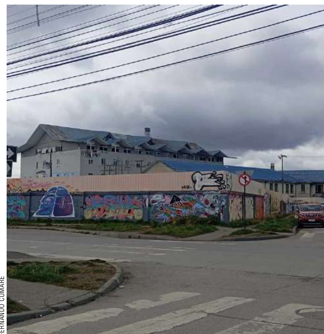
Como un inicio “administrativo” podría describirse lo ocurrido ayer en la obra de demolición del exhospital de Punta Arenas.
