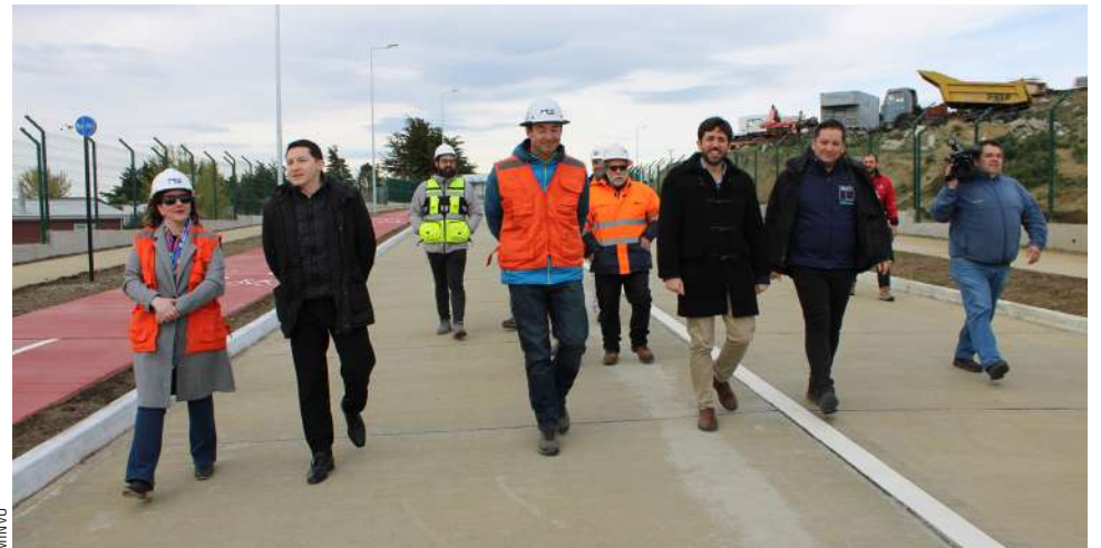
Las autoridades regionales recorrieron las obras, destacando la concreción de esta nueva etapa.
