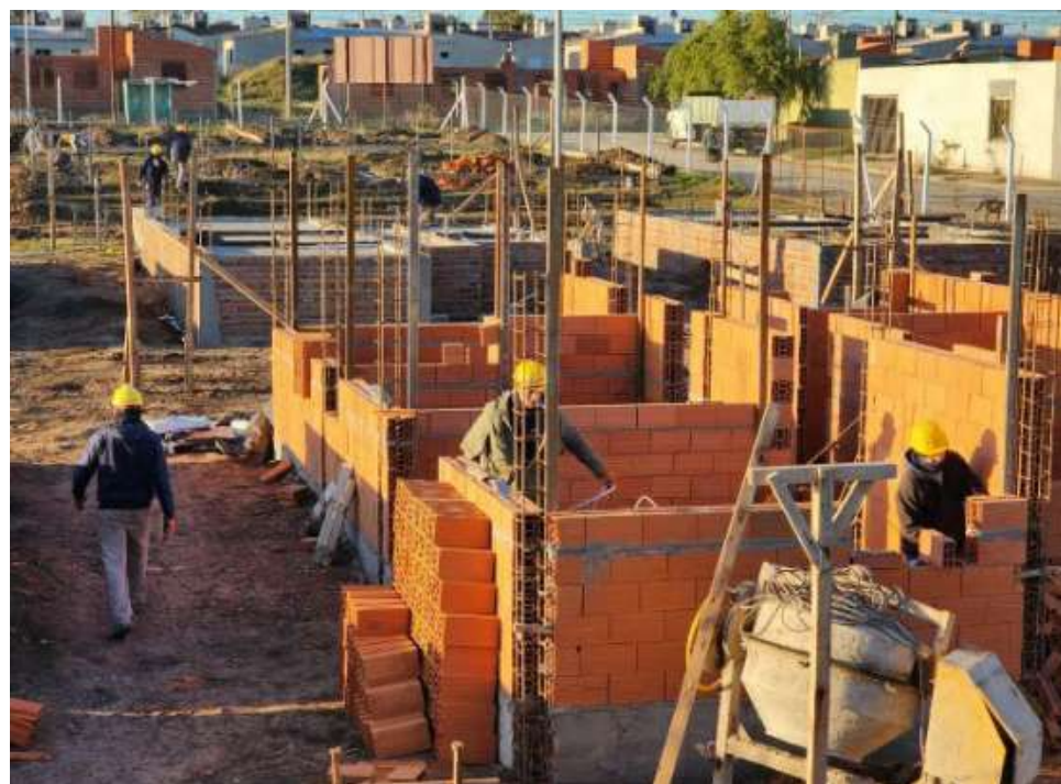
El ajuste cercano al 50% en los subsidios del programa 2026 del Minvu preocupa al sector por su eventual impacto en el acceso a la vivienda.
