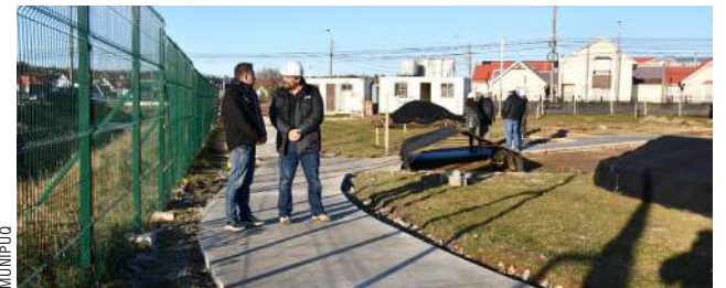
Avanzan las obras del Parque de Mascotas.
