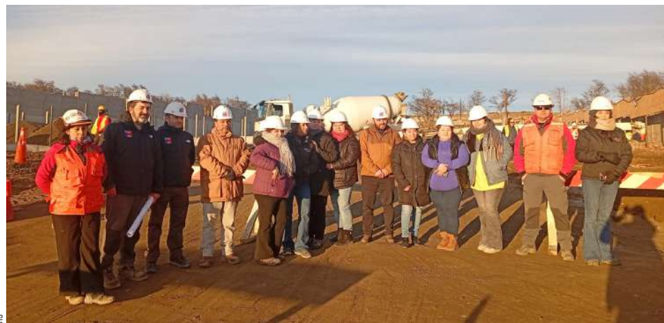
Las jefas de hogar visitaron las obras en compañía de las autoridades.
