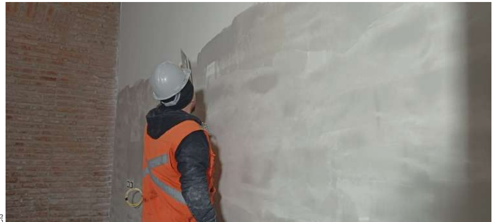
Trabajadores afinan las paredes del futuro Archivo Regional con el despliegue de estuco.
