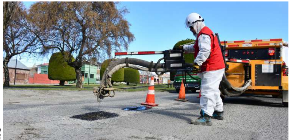
Municipio comienza con trabajos de asfalto en diferentes puntos de la ciudad.
