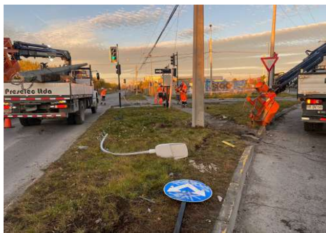
Varias unidades de emergencia de Edelmag trabajaron en la reposición.
