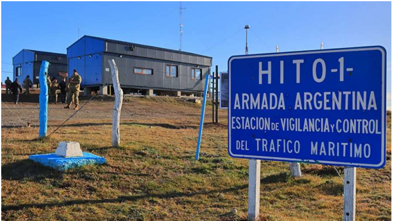
La construcción argentina en el Hito 1 en Magallanes.
