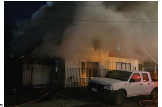
El incendio se desató los primeros días de septiembre del 2025 y afectó la segunda planta del inmueble.
