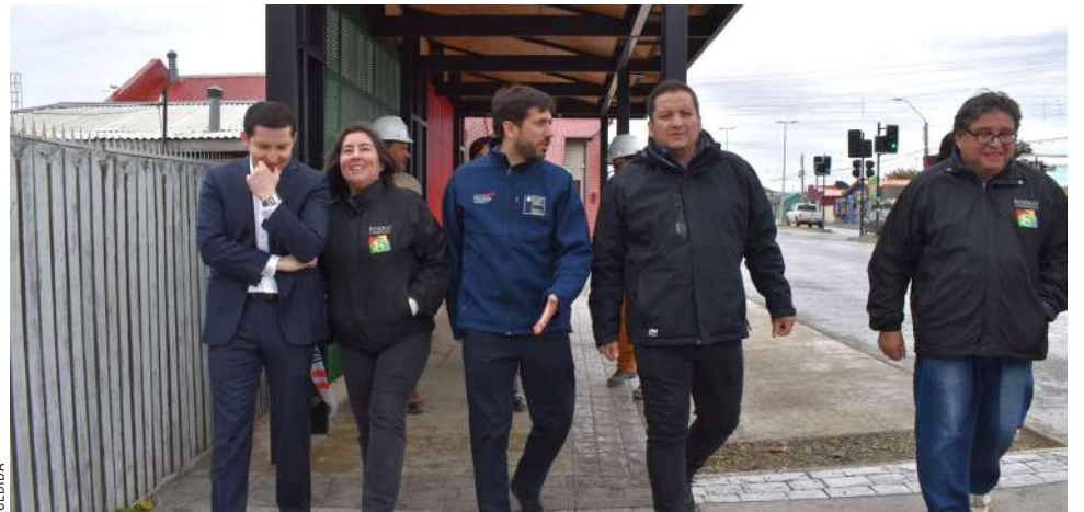
Con un avance del 20% en su primera etapa, las obras de mejoramiento del Barrio Comercial 18 de Septiembre avanzan según lo planificado.
