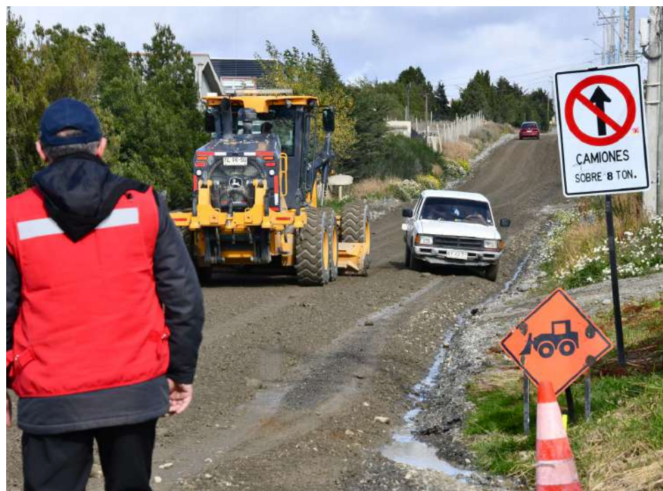
La maquinaria municipal trabajó y continuará trabajando en la reparación de los caminos.
