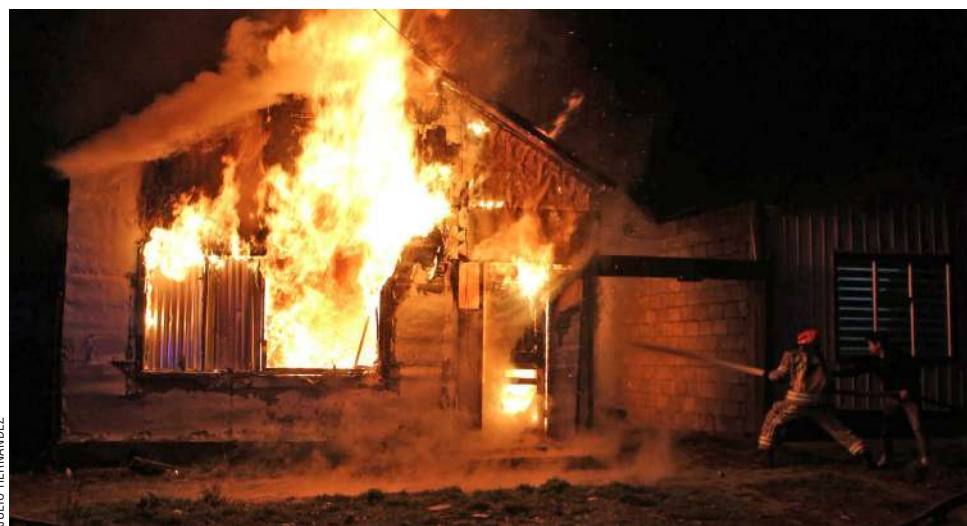
Las llamas se propagaron rápidamente a toda la estructura, Bomberos evitó la propagación.
