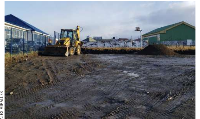
Trabajos en terrenos del Cesfam Mateo Bencur.
