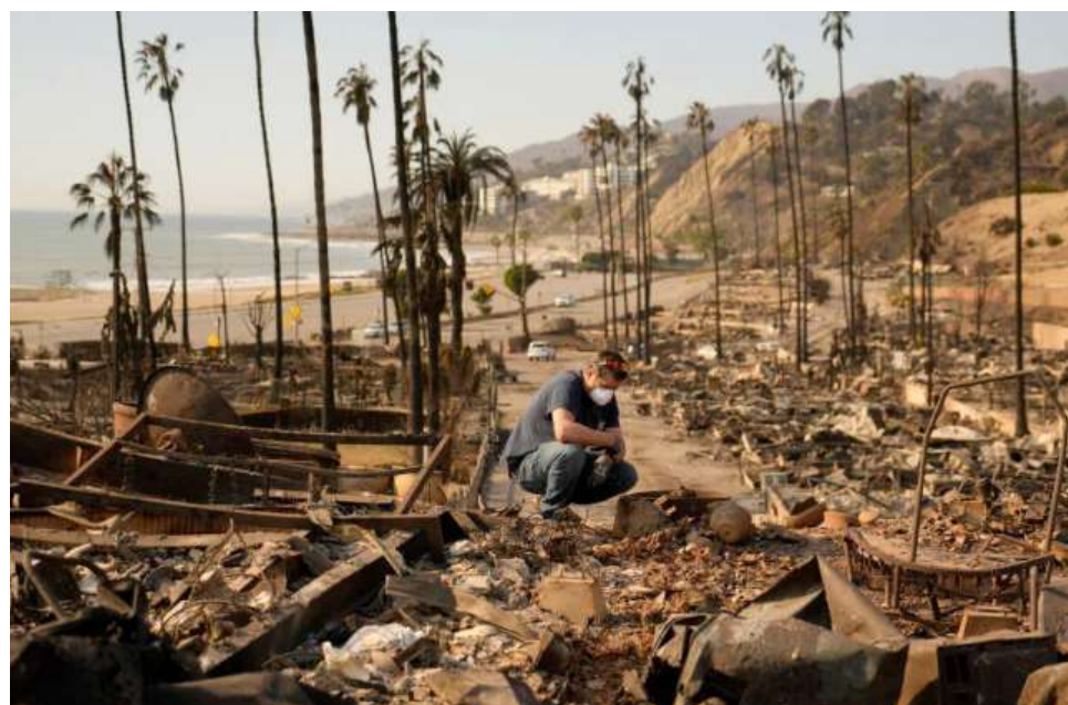
Un total de 27 personas fallecidas han dejado los incendios en California.
