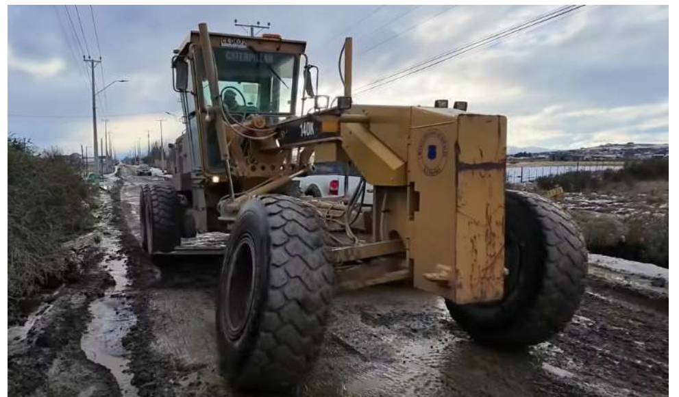
Una retroexcavadora y una motoniveladora fueron desplegadas para mejorar provisoriamente las condiciones de transitabilidad del sector.
