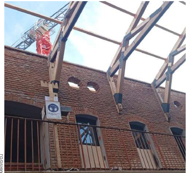
Los trabajos llevan un avance que supera el 60% en la obra gruesa.
