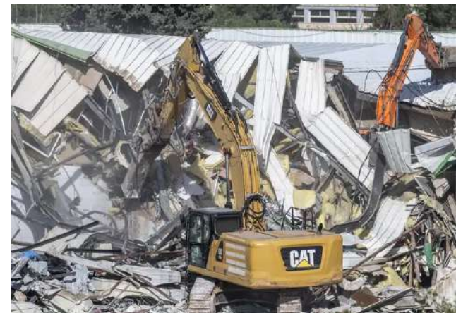
Con excavadoras se desarrolló la demolición de las instalaciones.
