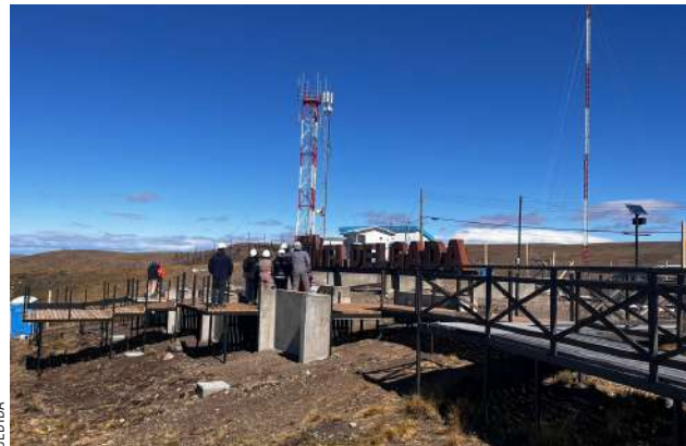
La futura portada de la villa contará con letras volumétricas de acero que darán la bienvenida a los visitantes.
