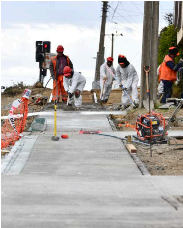
A paso firme se desarrollan los trabajos de reposición de veredas.
