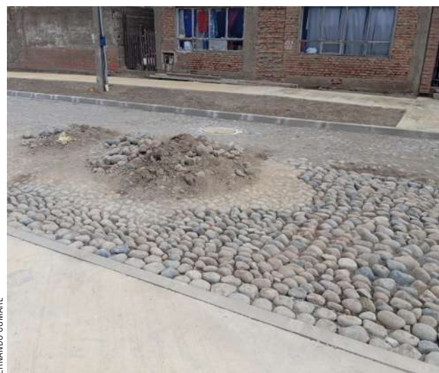
En Avenida Colón avanza la obra bajo la técnica ancestral croata.
