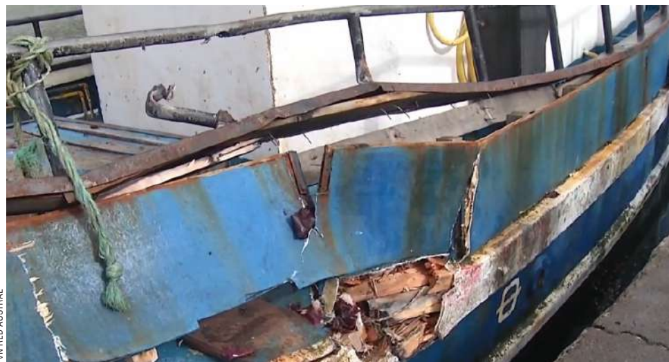
Estos son los daños que sufrió la embarcación luego del impacto, logrando llegar a la caleta de pescadores de Barranco Amarillo.
