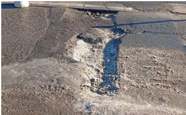
Comenzó el cierre perimetral en el sector que será intervenido.
