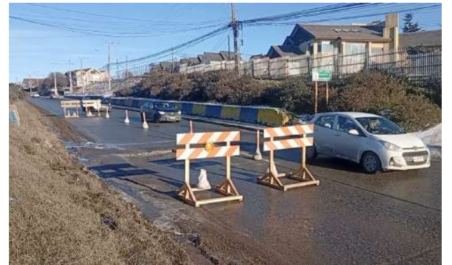
A mantener precaución en el sector, ya que mientras duren las obras funcionará solo una pista.
