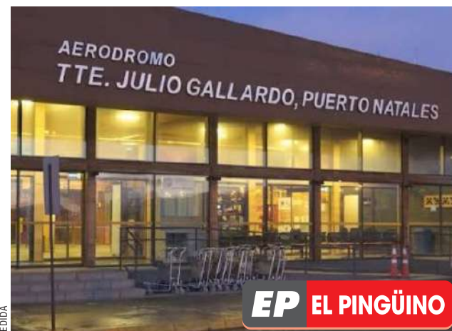
Los trabajos se ejecutarían entre enero y abril del próximo año.
