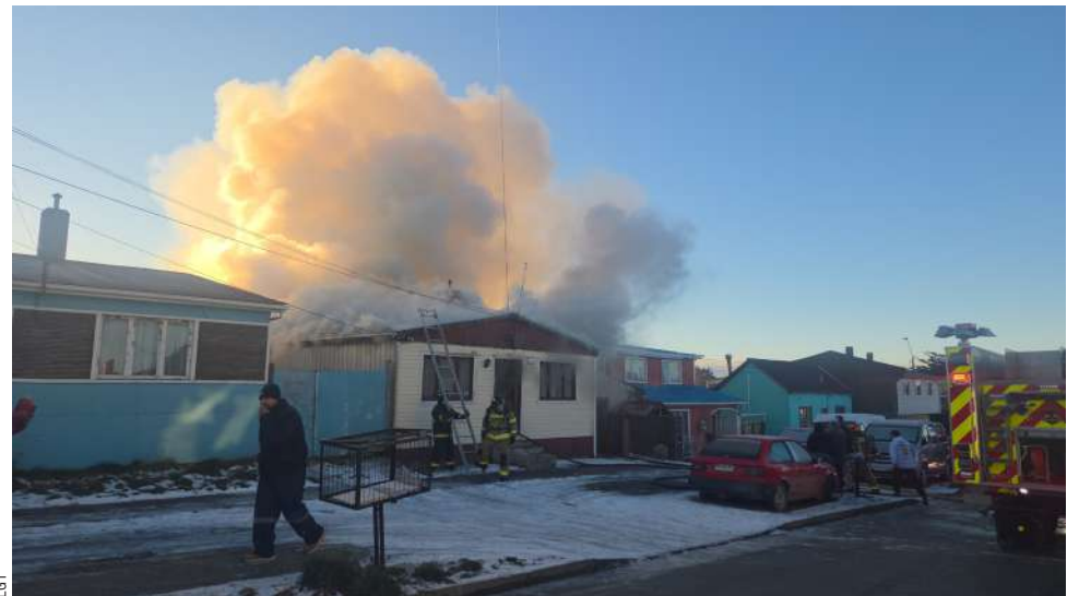
El fuego destruyó la parte posterior de la vivienda, y se propagó por el entretecho al resto de la estructura.
