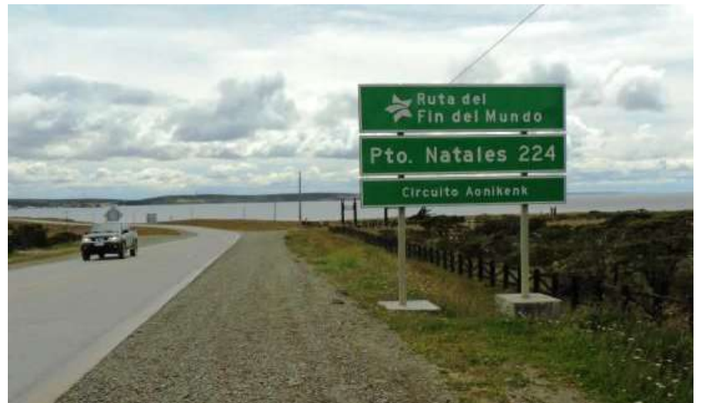
Una de las grandes falencias que presenta toda la extensión de la Ruta 9 Norte es la falta de iluminación.
