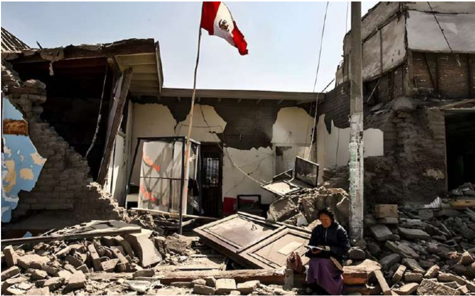
Deslizamiento de tierras y cortes de camino son parte de los problemas que generó el terremoto del jueves 20 de agosto.
