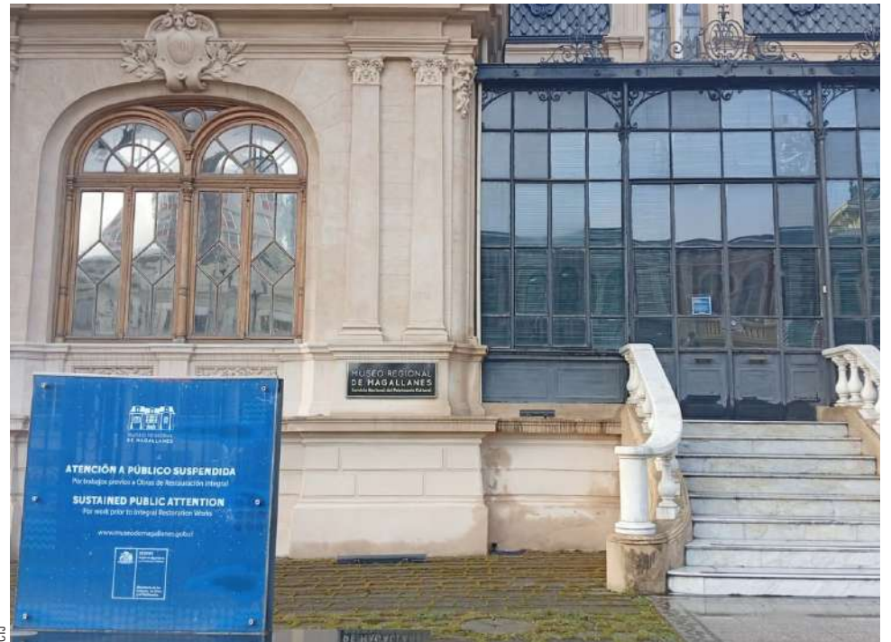
El inmueble permanece cerrado y los magallánicos añoran su reapertura para visitarlo.
