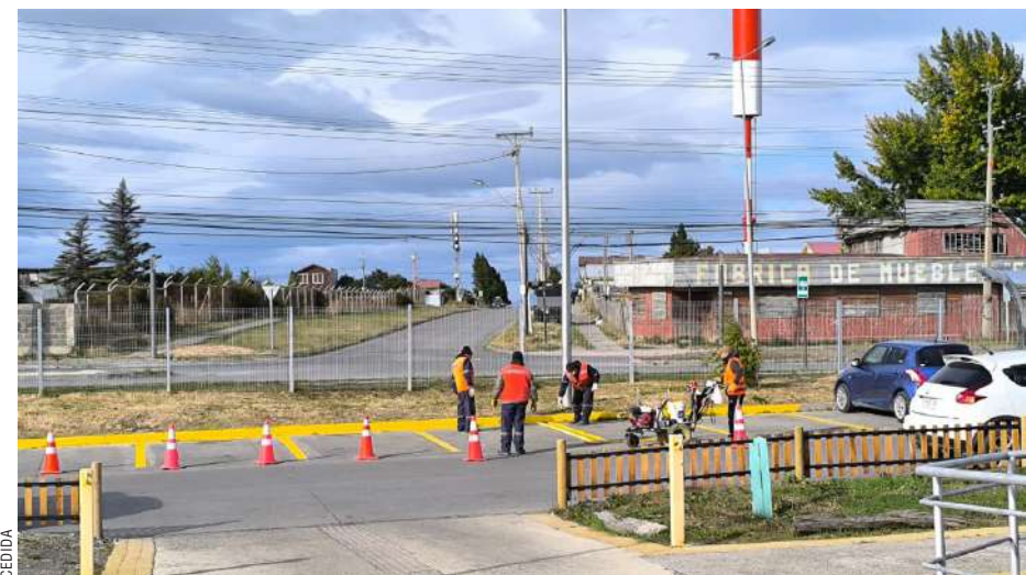
Funcionarios de la Municipalidad de Natales se encuentran realizando trabajos de pintura y demarcación en el Hospital Dr. Augusto Essmann Burgos.
